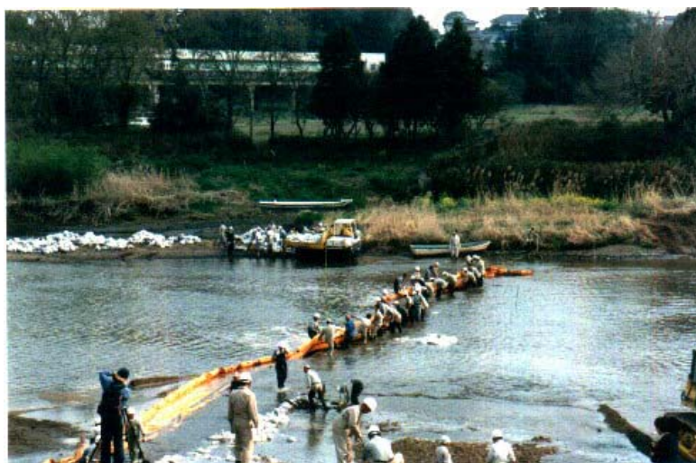
写真 5-1 渇水時における塩水流入防護フェンス設置の作業状況（平成8年4月）
