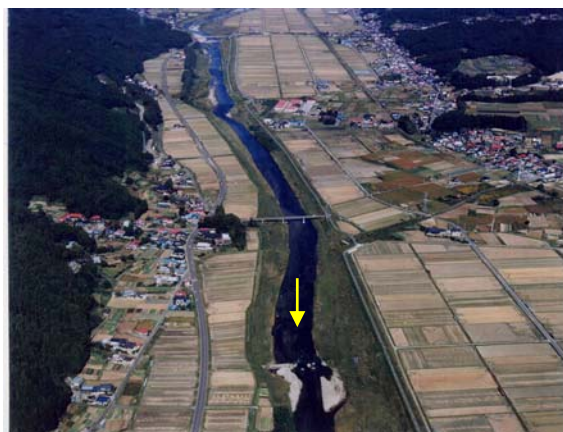
河口から 88km (矢祭橋)
