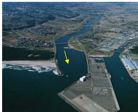
河口から 0.0km (東海村・日立市)
