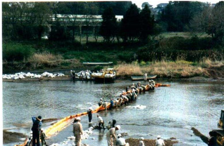
写真 5-1 渇水時における塩水流入防護フェンス設置の作業状況（平成8年4月）
