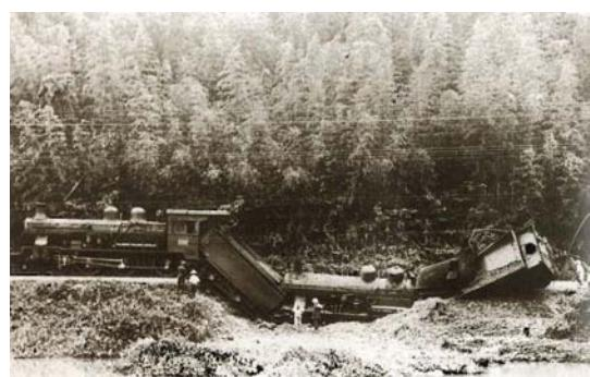
破堤し道床が流出したため、脱線した機関車
