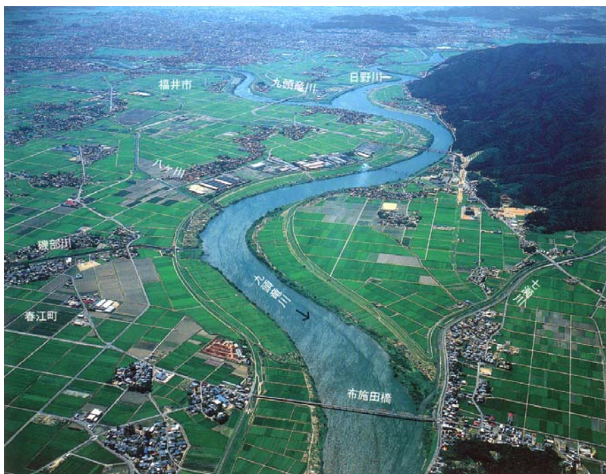
図 8-10 布施田橋付近
