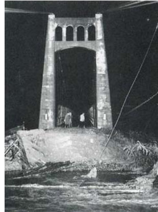
鳴鹿橋の流出 （福井新聞社提供）
