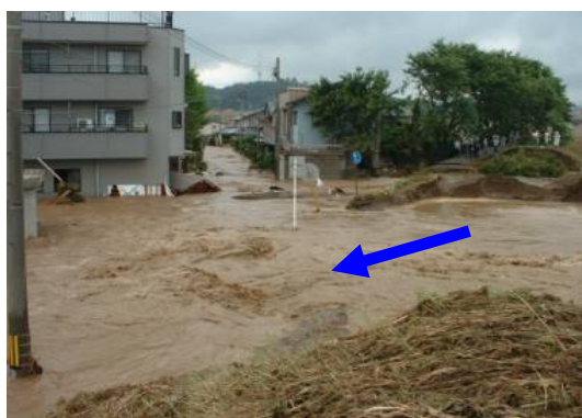
破堤部の状況（福井市春日）
