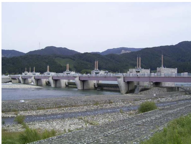
九頭竜川鳴鹿大堰
