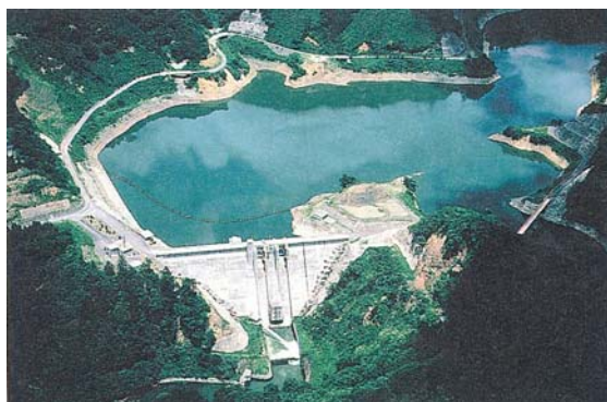
広野ダム本体
