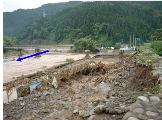
落橋した越美北線橋梁と被災した堤防の状況 (福井市安波賀)
