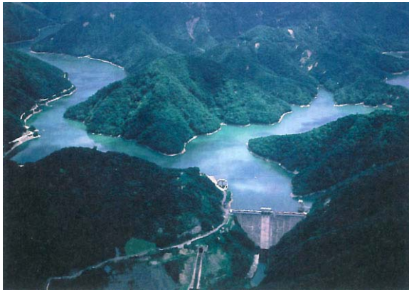
笹生川ダム本体
