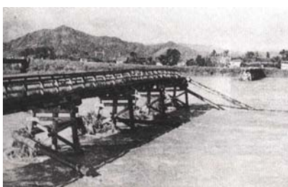
鯖江市神明町北野付近 吉川橋（県道青野鯖江線）が流失
