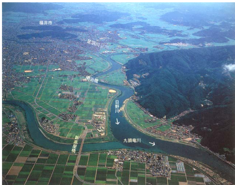
図 8-12 九頭竜川合流点付近
