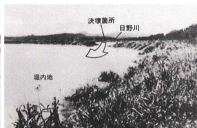
福井市三郎丸付近 日野川の破堤箇所を望む
