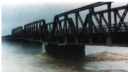
福井市高屋付近高屋橋(県道福井三国線)の橋脚が洗掘のため傾いた
