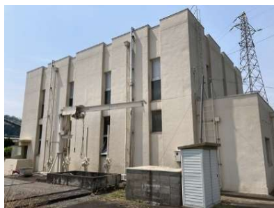
下網場ポンプ場(養父市)
