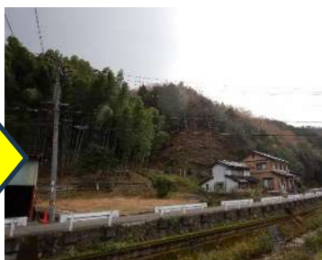
施工後(養父市川東区)
