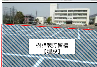
地下貯留施設の取組事例(豊岡市) 豊岡総合庁舎駐車場地下貯留施設(1,800m 3 )
