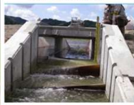
魚道つき起伏ゲート
