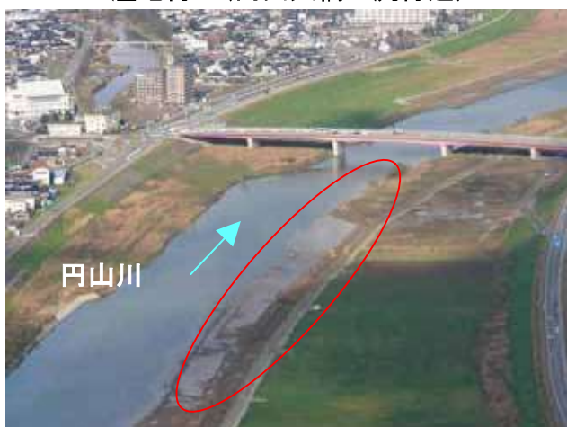
湿地再生(円山大橋上流付近)
