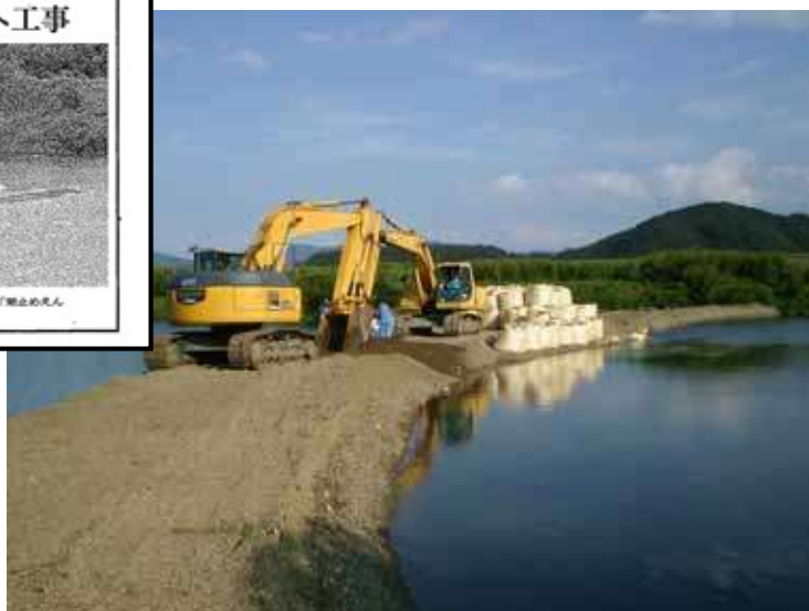
潮止め堰の工事写真
