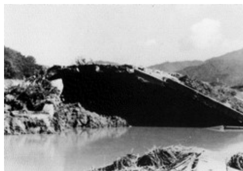
国道178号福田橋付近
