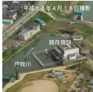
既存の豊岡排水機場
