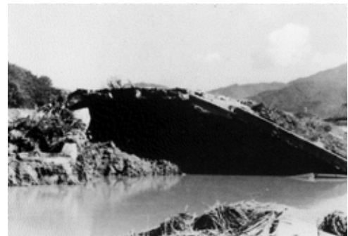
国道178号福田橋付近
