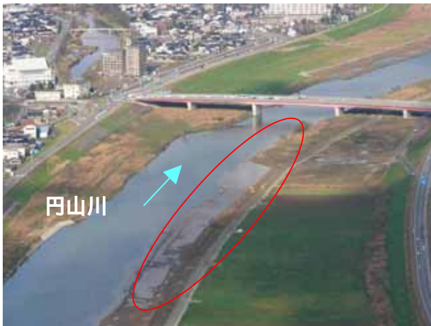
湿地再生(円山大橋上流付近)
