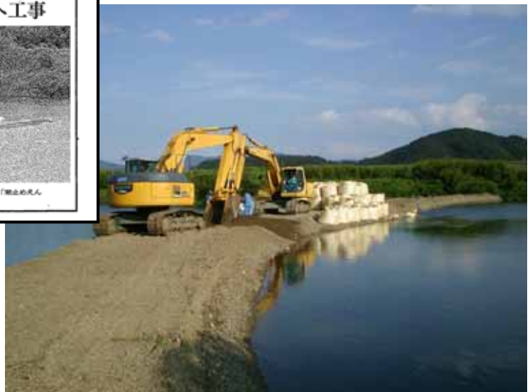
潮止め堰の工事写真
