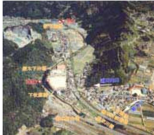
【厳木川 10k0 付近】
