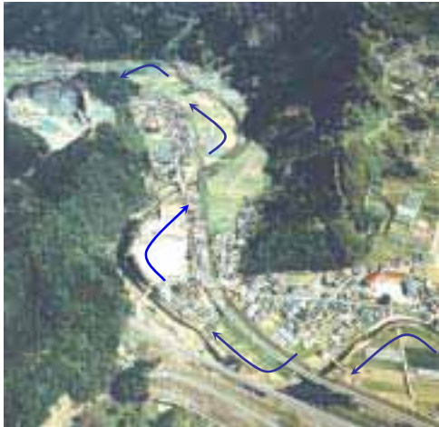
【巖木川 10k0 付近の蛇行状況】
