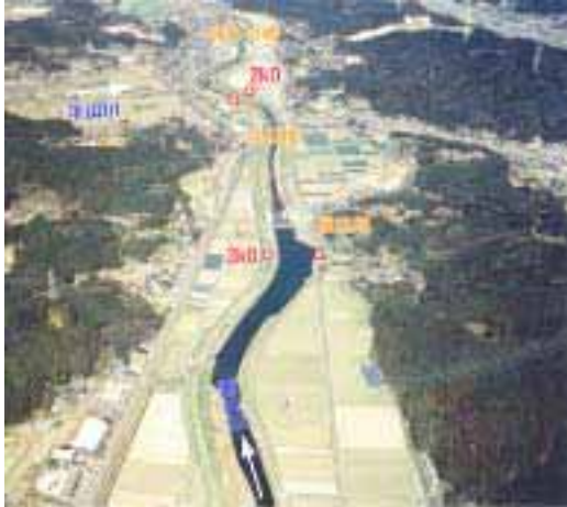
【厳木川横枕堰付近】
