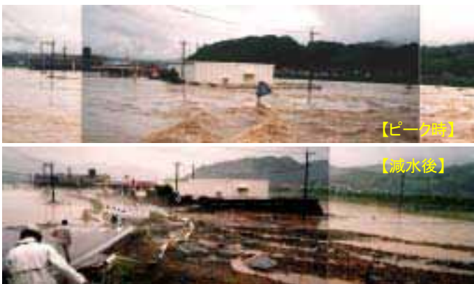
【松浦川 川西橋下流(25k000 付近)】
