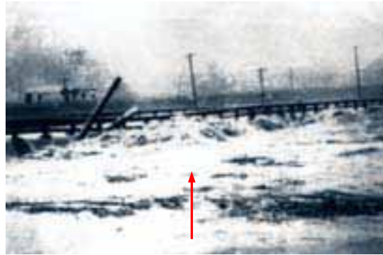
【厳木川 厳木橋(9k900 付近)】
