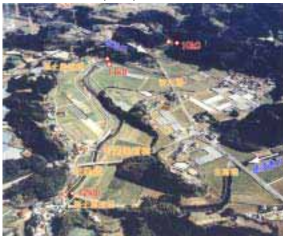
【水留地区(12k0)付近の河道の状況】
