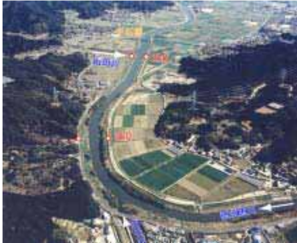
【田中川合流点付近の河道の状況】
