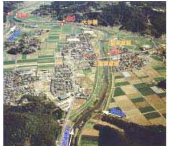
【稗田川合流点付近の河道の状況】
