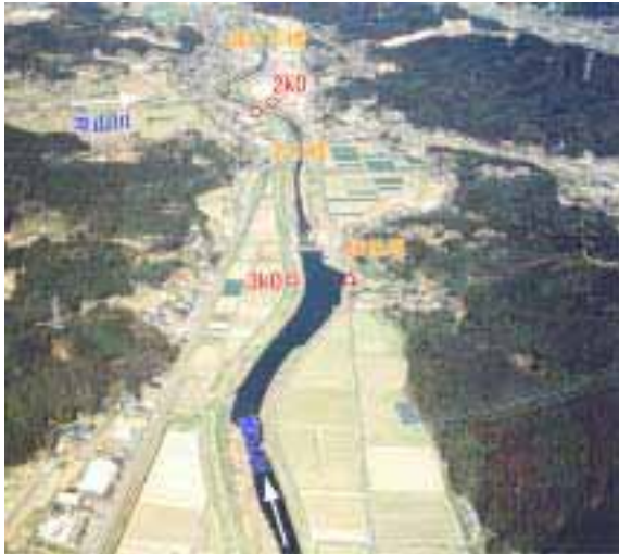
【横枕堰付近の河道の状況】
