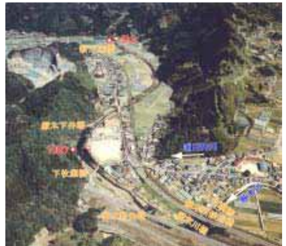
【10k0 付近の河道の状況】
