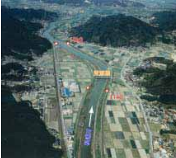
【11k0 付近の河道の状況】
