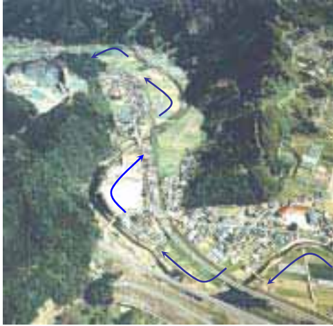
【巖木川 10k0 付近の蛇行状況】
