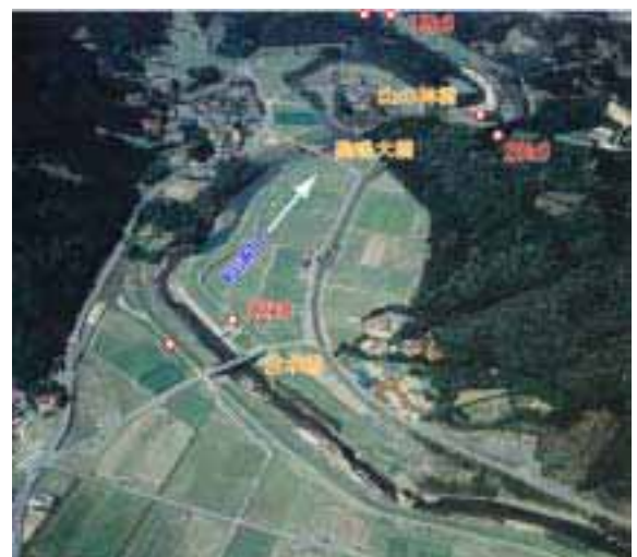
【22k0 付近の河道の状況】
