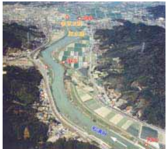
【9k0 付近の河道の状況】
