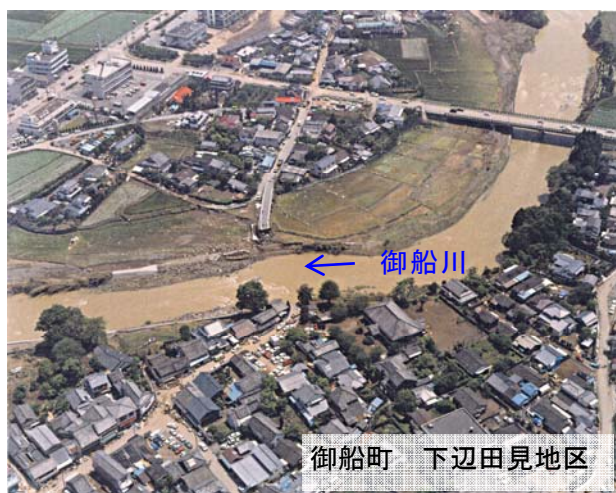
写真 4-3 昭和 63 年 5 月洪水時の状況 (出典：熊本河川国道事務所)
