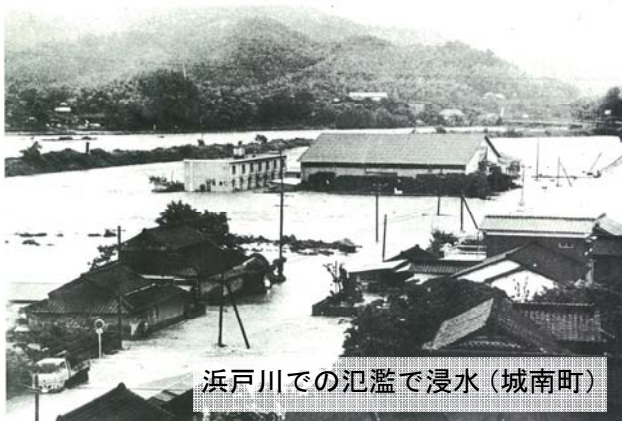
写真 4-1 昭和47年7月洪水時の状況 (出典：緑川水系流域概要 建設省 S57.3)
