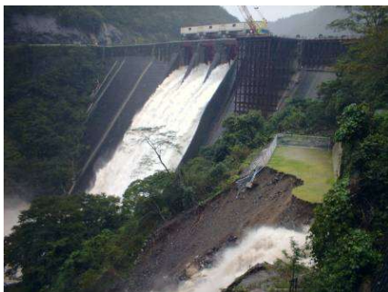
宮川ダムの放流状況
