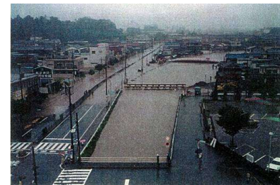
八束橋より下流の状況
