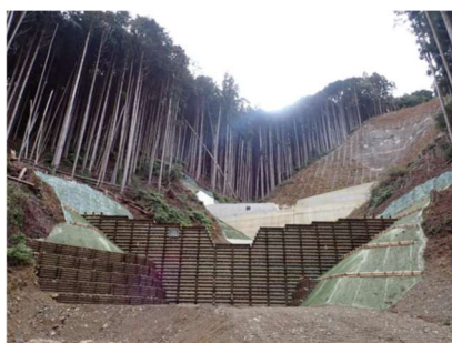
図 4-22 治山ダムの整備事例（大紀町）
