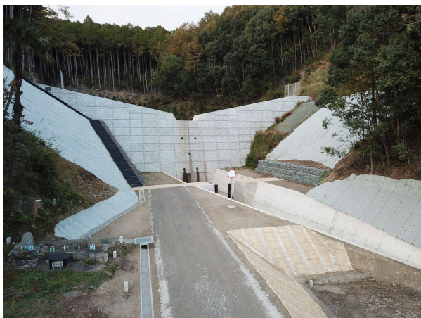
図 2.2 砂防施設の整備事例（度会町）
