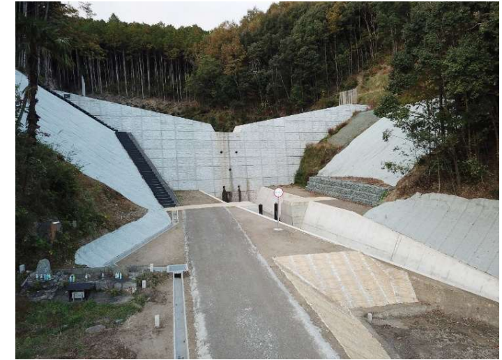
砂防堰堤の整備事例(度会町)
