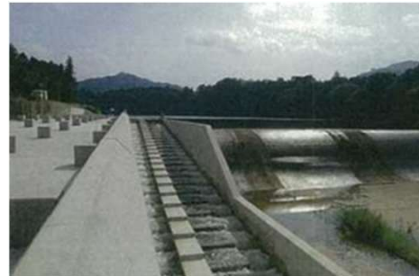
頭首工右岸の放流工に魚道を整備
