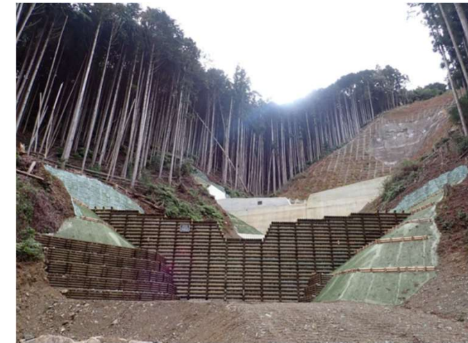
治山ダムの整備事例(大紀町)
