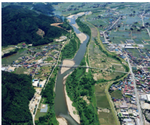
長井大橋付近 (長井市)
