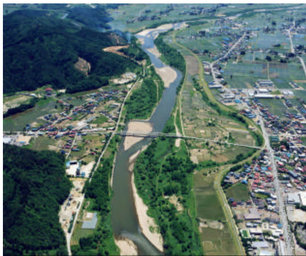
長井大橋付近 (長井市)
