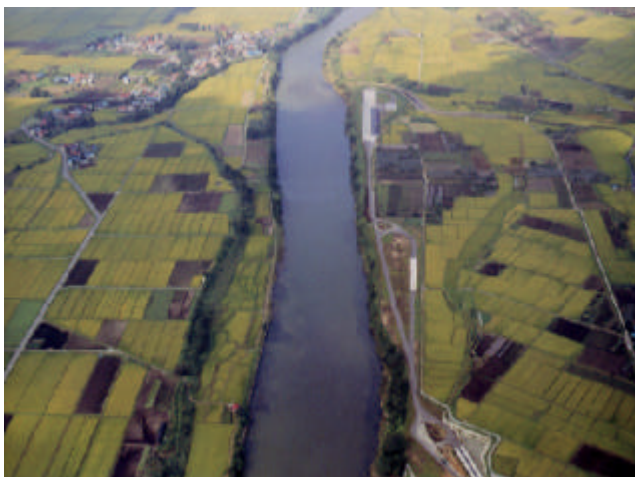
狭窄部 河口から91.1km付近
