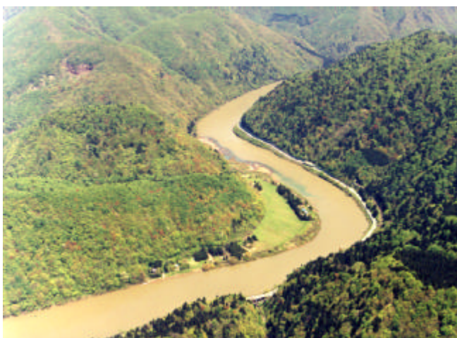
狭窄部（最上峡） 河口から33km付近
