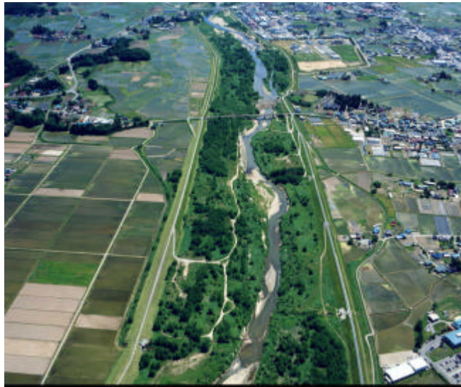
置賜橋付近 (米沢市)
