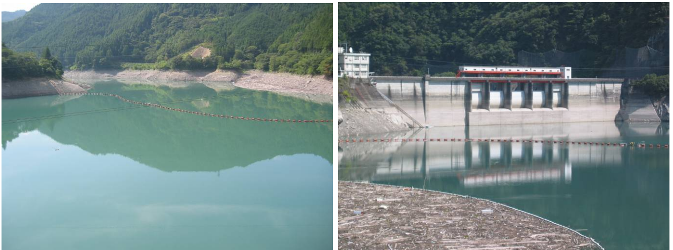
図 5.3.2 永瀬ダム湧水状況写真（平成 17 年 8 月 17 日）
