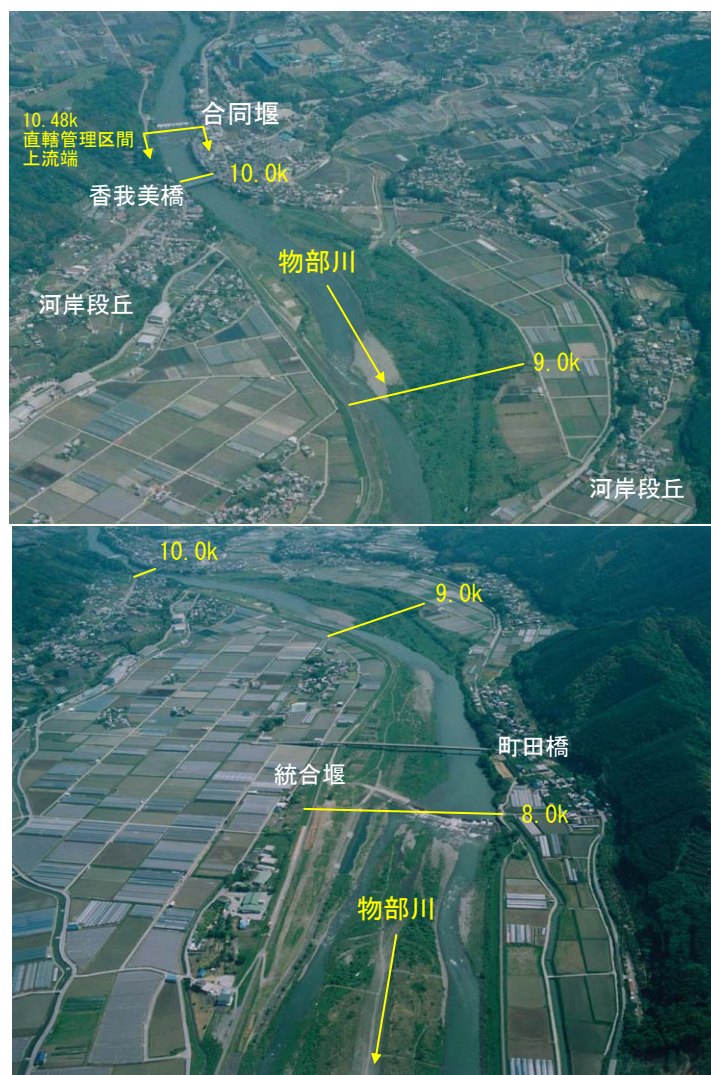
図 8.1.1 統合堰～合同堰
