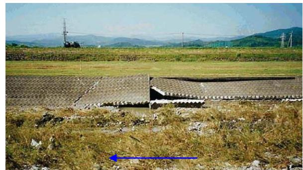
平成10年9月洪水での統合堰下流の低水護岸の被災
