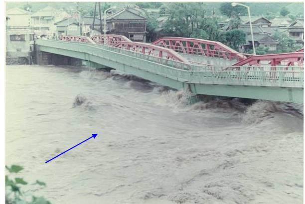
昭和47年7月洪水での香我美橋の橋脚の被災
