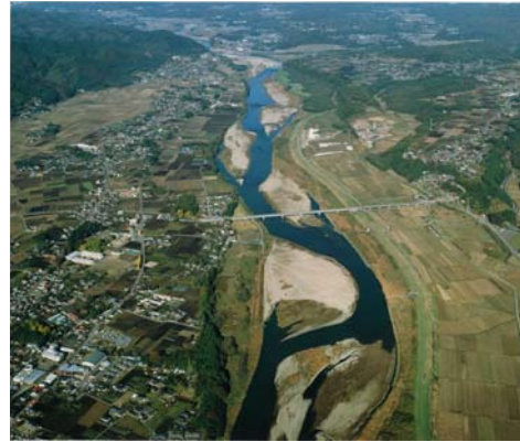
33.0 km 付近の河道の状況
