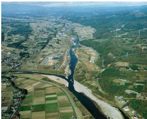
85.0kmの河道の状況（箒川合流点付近）
