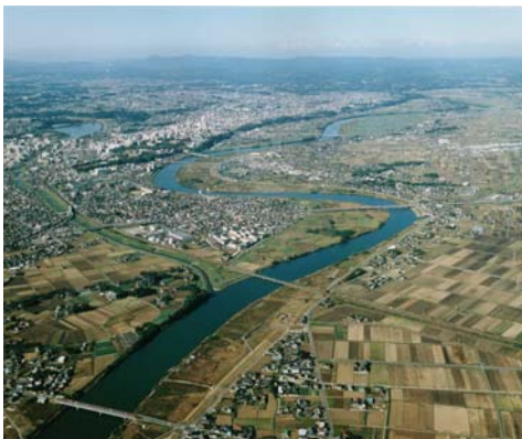
8.0km 付近の河道の状況
