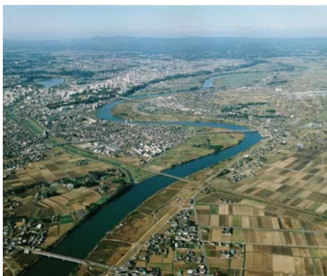
8.0km 付近の河道の状況
