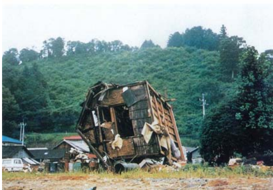
▲洪水によって流された家屋 (那須烏山市)
