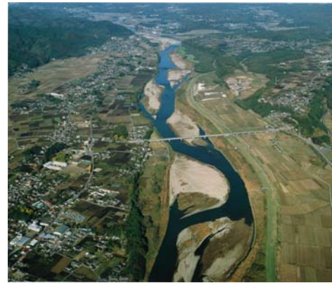
33.0 km 付近の河道の状況
