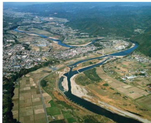
63.5km付近の河道の様子
