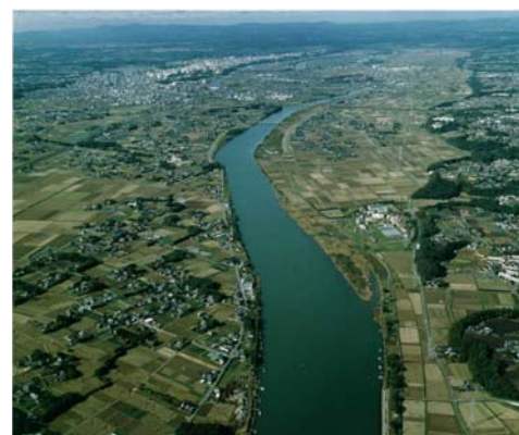
5.0 km 付近の河道の状況
