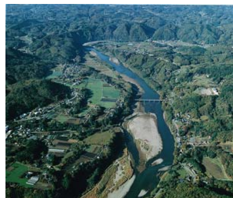
50.0km付近の河道の状況
