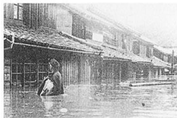
那賀町（旧鷲敷町）和食地区の浸水状況（昭和25年9月）
