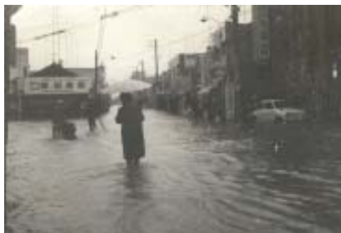
国道55号線阿南市富岡地区市街地の浸水状況 （昭和40年 9 月14日）
