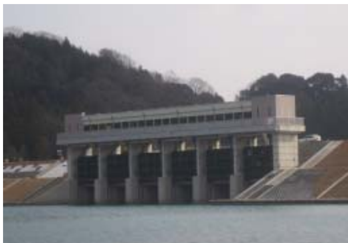
熊谷川樋門（吉井箇所改修事業）
