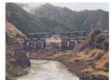
川口ダム (徳島県) 川口発電所 ・ 那賀町古野 ・ 位置/那賀町古野
