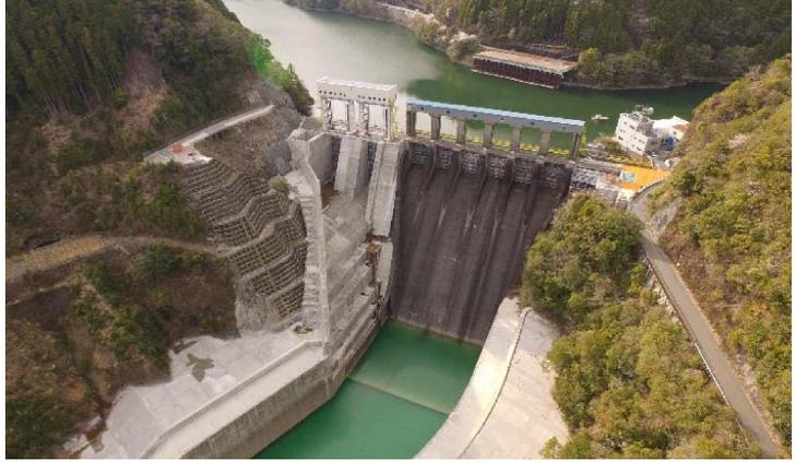
容量の有効活用を目的として洪水吐ゲートを2門増設等の改造を実施し令和2年度にダム本体改造工事が完了。
