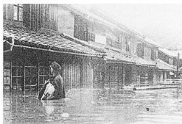
那賀町（旧鷺敷町）和食地区の浸水状況（昭和25年9月）
