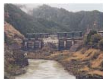
川口ダム（徳島県）川口発電所 ・ 那賀町古野 ・ 位置／那賀町古野
