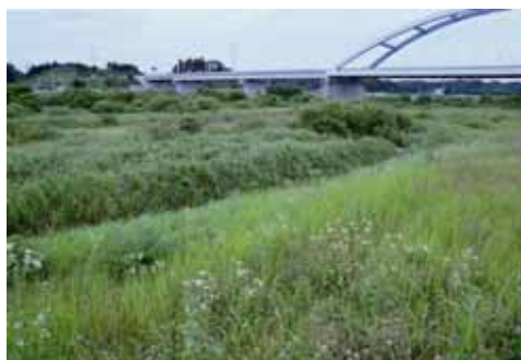
背割堤防区間の植生状況/北上川下流河川事務所
