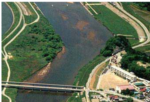
鳴瀬川の高水敷の状況/北上川下流河川事務所
