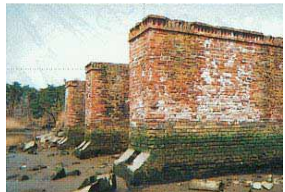
野蒜築港計画で建設された橋脚 (北上川下流河川事務所資料)
