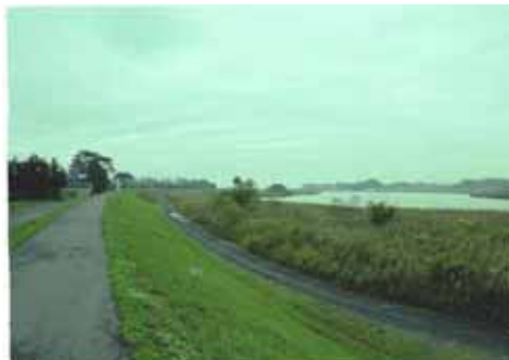
鳴瀬川の高水敷の状況/北上川下流河川事務所
