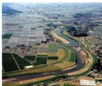
鳴瀬川中流堰(H14完成)
