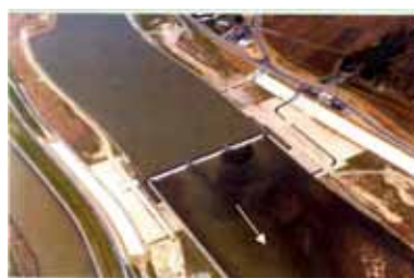
鳴瀬堰(H2完成)
