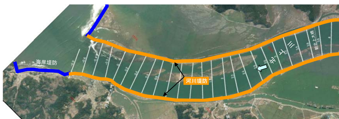
図 3-7 北上川 河口周辺の状況
