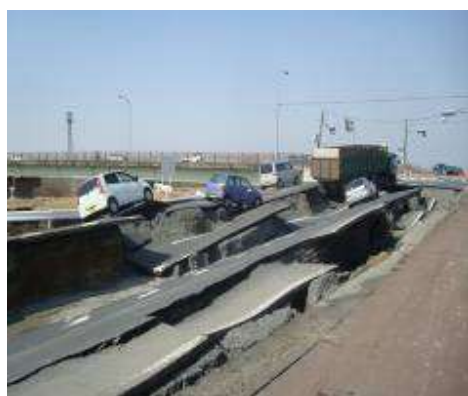
江合川左岸 27.6k 付近 (大崎市古川湊尻地先) ※地震により縦断クラック発生
