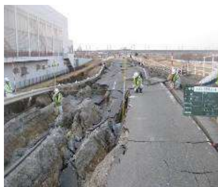
江合川右岸 26.6k 付近 (大崎市古川福沼地先) ※地震により縦断クラック発生
