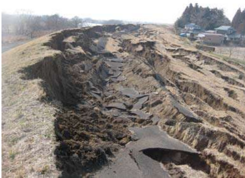
鳴瀬川左岸 30.3k 付近 (大崎市古川下中ノ目地先) ※地震により縦断クラック発生
