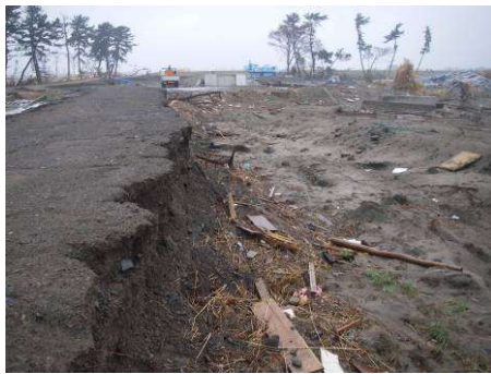
名取川左岸 0.0k 付近 (仙台市若林区藤塚地先) ※津波により堤防が流出
