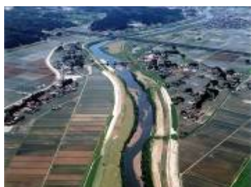
桑折江堰(H15 完成)
