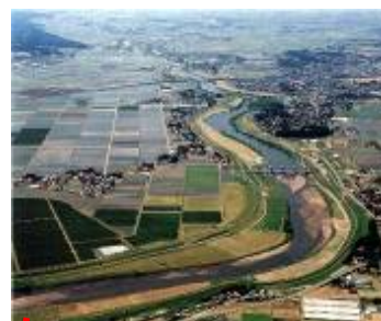
鳴瀬川中流堰(H14 完成)
