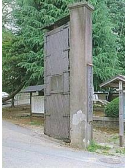
小川水門（北上川下流河川事務所）
