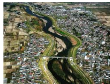
下流部/北上川下流河川事務所
