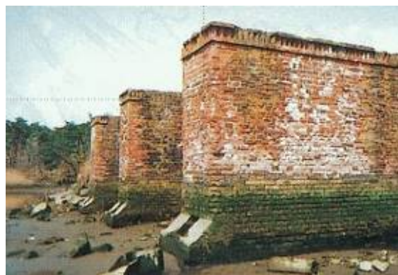
野蒜築港計画で建設された橋脚
