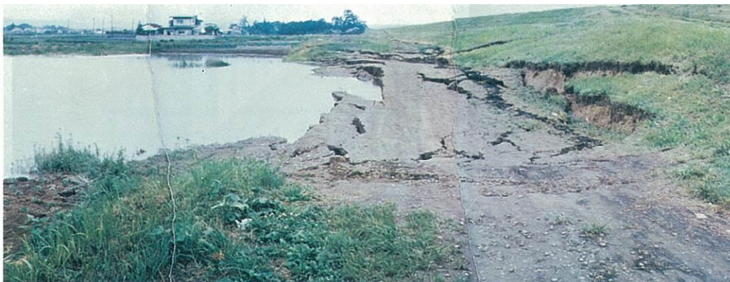
▲千代大橋橋脚上部のコンクリート剥離と鉄筋座屈(上左) 堤防天端縦断亀裂と特殊堤の傾斜 名取市閑上(上右) 堤防裏法面のすべりによる亀裂 名取川右岸・名取市鍋沼(下)
