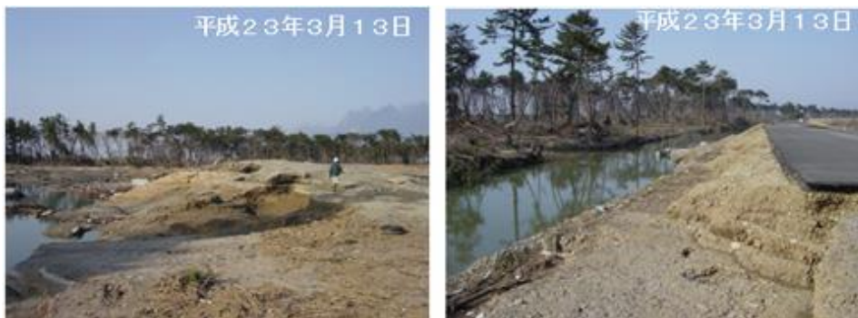
堤防の侵食・決壊、裏側の深掘れ（平成 23 年 3 月 13 日撮影）
