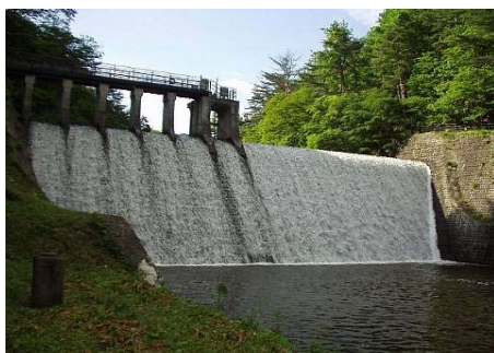
▲青下第二ダム
