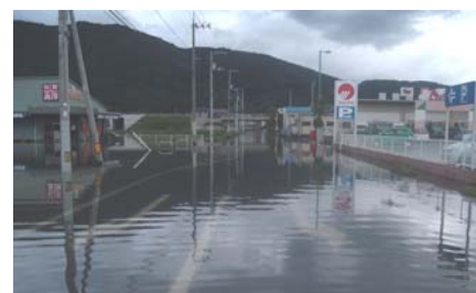
（蓮池地区：土佐市市街地の内水はん濫） 平成 17 年 9 月洪水浸水状況
