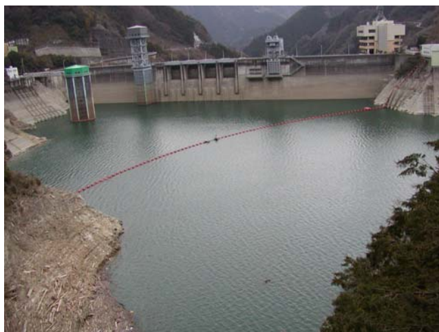
大渡ダム（平成 17 年渇水）
