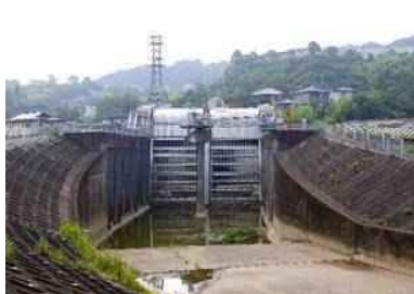
日下川放水路
