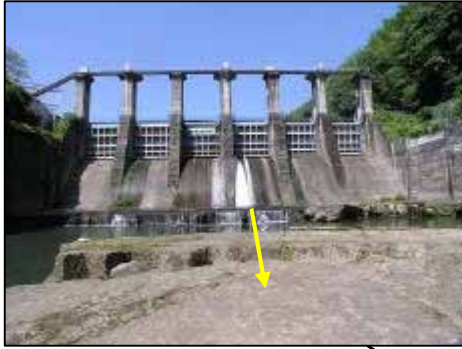
しのけら 篠原ダム 最下流端の発電用ダム
