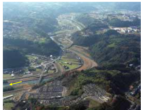
【7.0k 大分市廻栖野付近の河道の状況】
