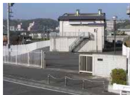
尼ヶ瀬排水機場
