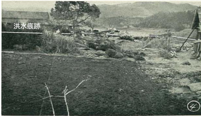
写真4-1 昭和29年9月洪水被害状況（高鍋町） (写真：国土交通省 宮崎河川国道事務所)
