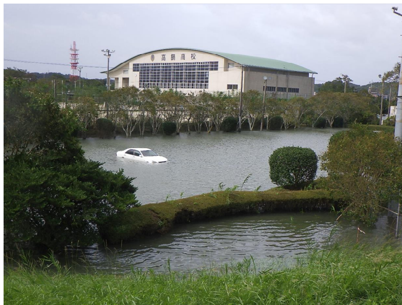
内水浸水状況（高鍋町営野球場）
