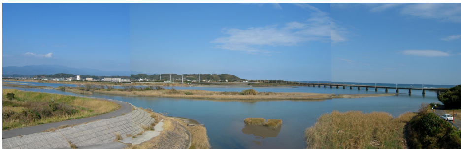
写真 8-5 宮田川より小丸川河口を望む
