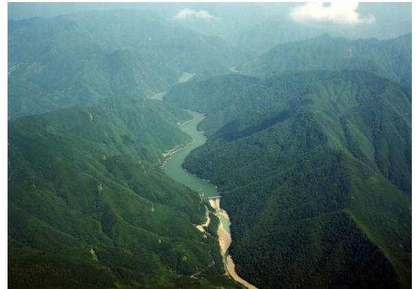
【小丸川上流部（松尾ダム付近）】
