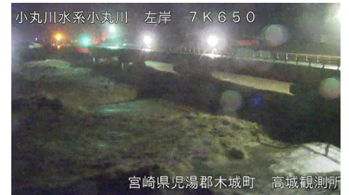
宮崎県児湯郡木城町 高城観測所 小丸川7k650付近 出水状況 (9月18日23:00頃)
