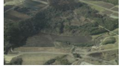
高鍋防災ダム
