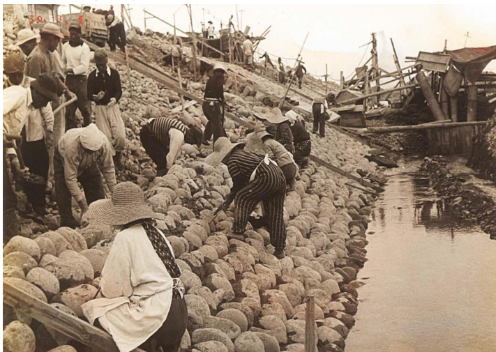
昭和26年堤防整備状況
