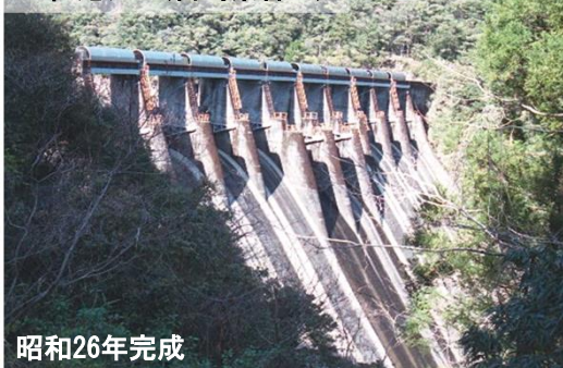
■ 松尾ダム(宮崎県管理)
