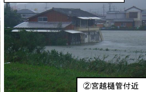
平成17年9月の浸水状況
