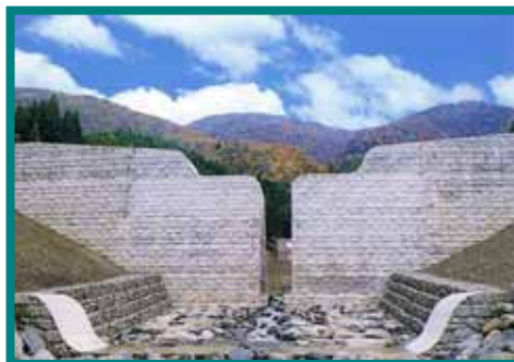
黒沢川第 1 砂防えん堤
