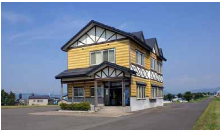
十文字河川防災ステーション
