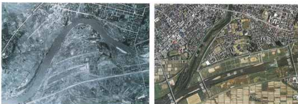
大曲捷水路改修工事着工前（昭和 36 年） 大曲捷水路完成後（平成 11 年）
