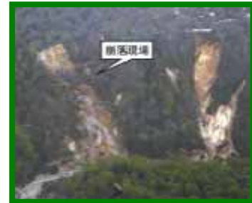
先達川被害状況(H9)
