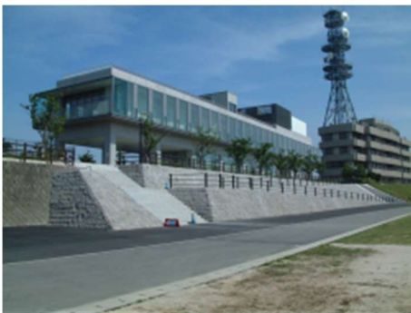
図 7-2-7 遠賀川地域防災施設 「遠賀川水辺館」(直方市)
