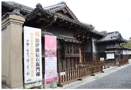
図 2-3-5 旧伊藤伝右衛門邸(福岡県飯塚市) 写真：遠賀川河川事務所
