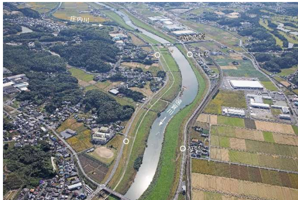
図 8-1-2 遠賀川中流部 (23k 付近)
