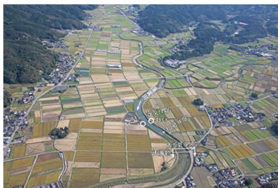
図 2-2-1 遠賀川上流部(嘉麻市)
