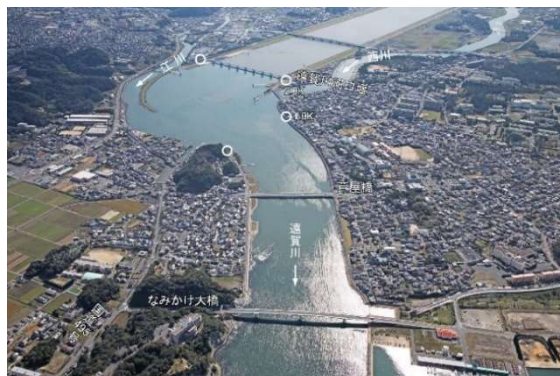
図 2-2-13 遠賀川下流部 (芦屋町、河口部より上流より望む)
