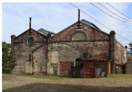
図 2-3-4 遠賀川水源地ポンプ室
