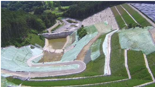
太陽光発電に係る洪水調節池の整備状況
