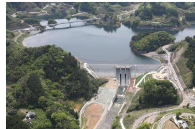
○ 気候変動による降雨量の増加等を考慮し設定した基本高水のピーク流量13,500m<sup>3</sup>/sを、流域内の洪水調節施設等により2,400m<sup>3</sup>/s調節し、河道への配分流量を11,100m<sup>3</sup>/sとする。
