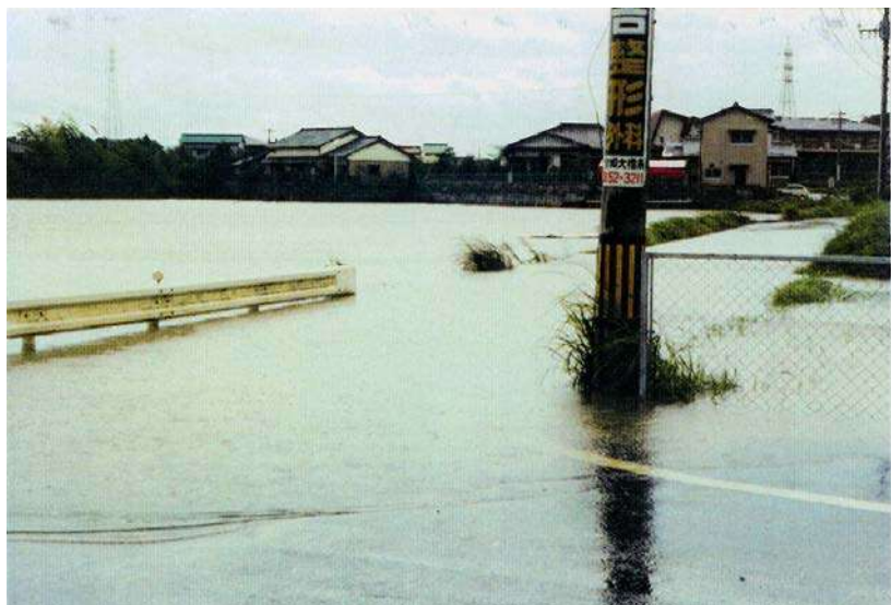
下小松地区 (8/000右岸付近) 浸水状況
