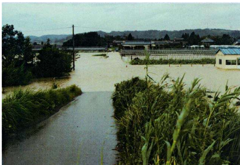
下小松地区 (8/000右岸付近) 浸水状況
