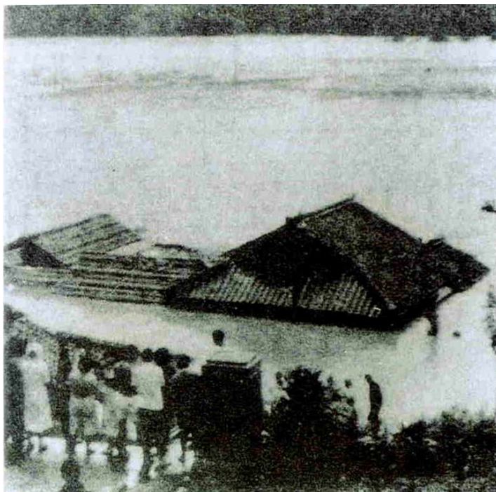
軒先まで浸水した家 (宮崎市高岡町)
