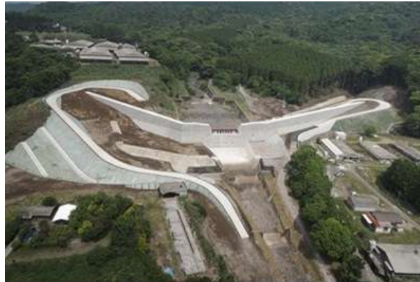
砂防堰堤の整備状況（望原谷第 1 砂防堰堤）
