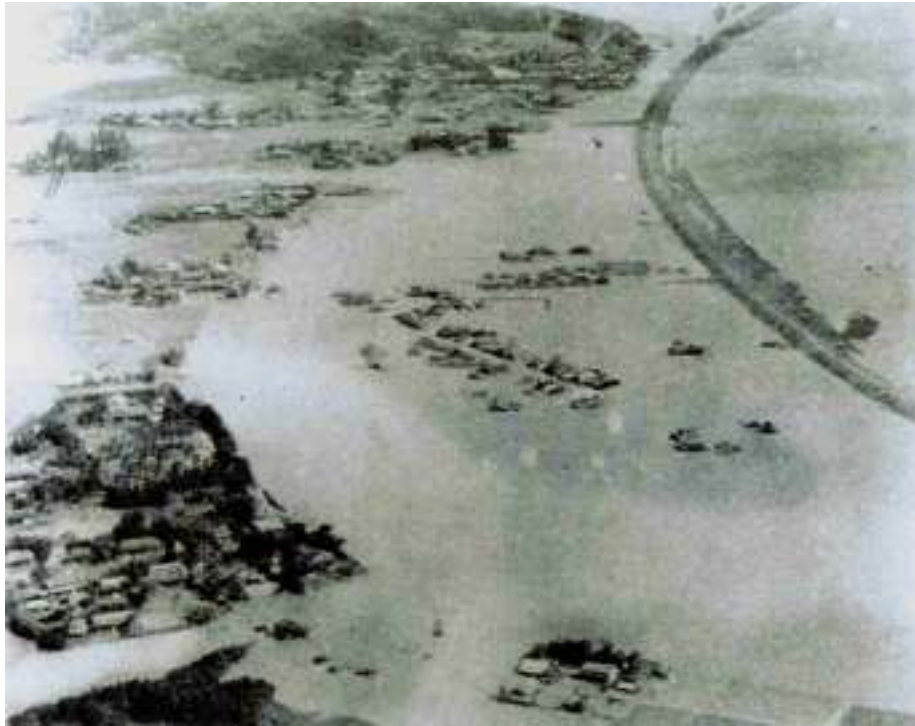
右岸大塚町付近の浸水状況（宮崎市）
