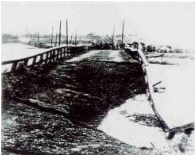
流出寸前の赤星橋 （都城市）
