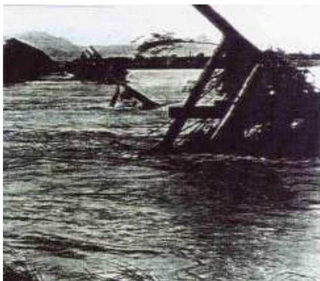
流出した高松橋(宮崎市)
