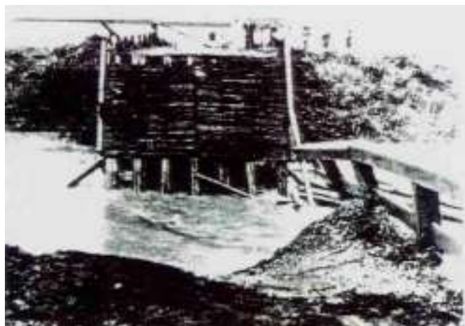
源野橋の流失 （都城市・横市川）
