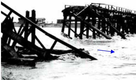
落橋した国条橋（高岡市長江）
