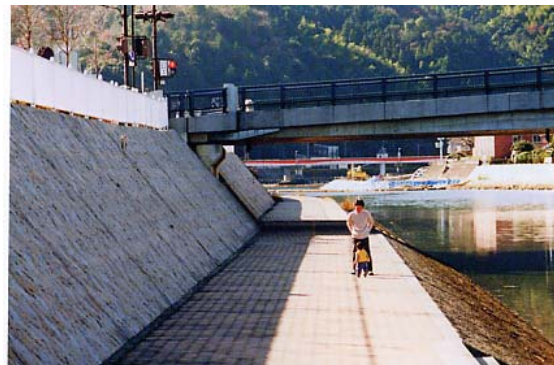
大和橋右岸アンダーパス(散策道)
