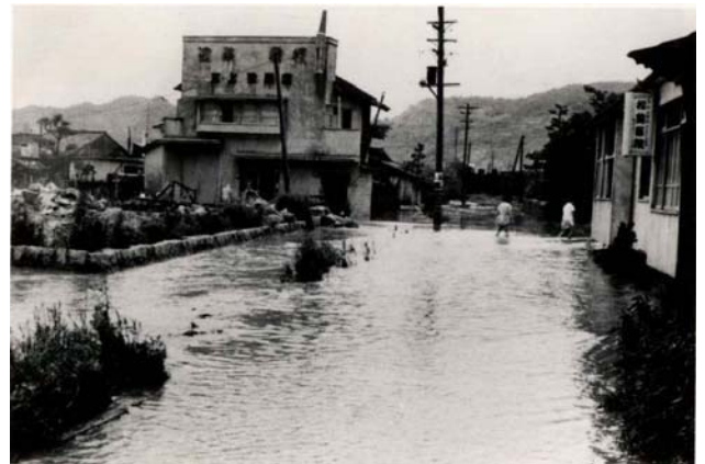
大竹町内(当時)の浸水状況
