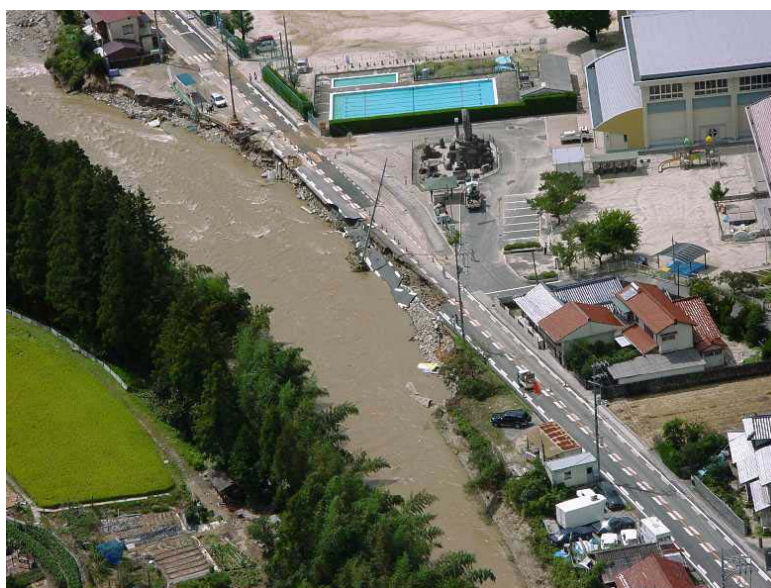
玖島川の被災状況(広島県廿日市市)
