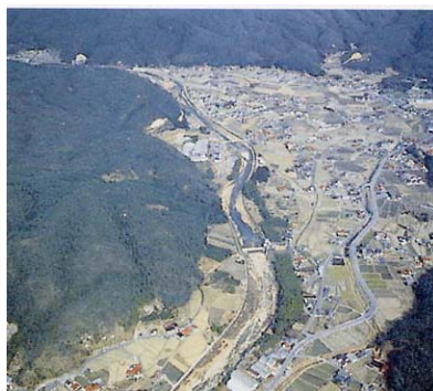
小瀬川上流部 (39K 付近) 中国山地の山あいを抜けた後、廿日市市佐伯地区の盆地を流下し、河床勾配は緩やかとなる。
